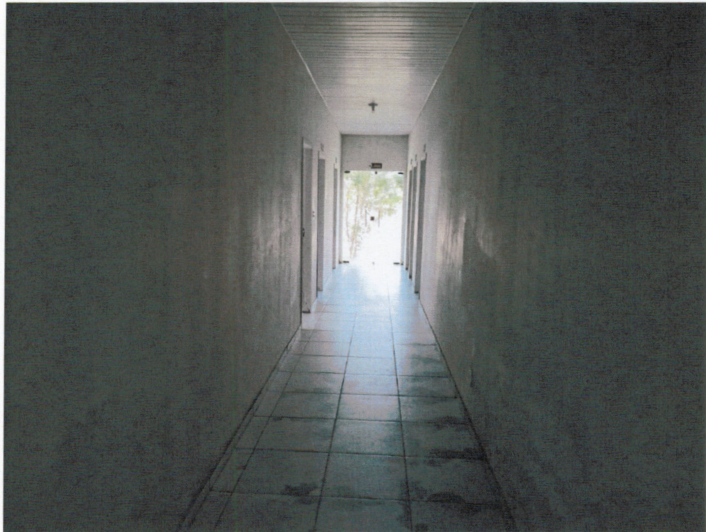
Foto 07: Reg. fotográfico da situação-Engenharia e Fiscalização/SEMUST
