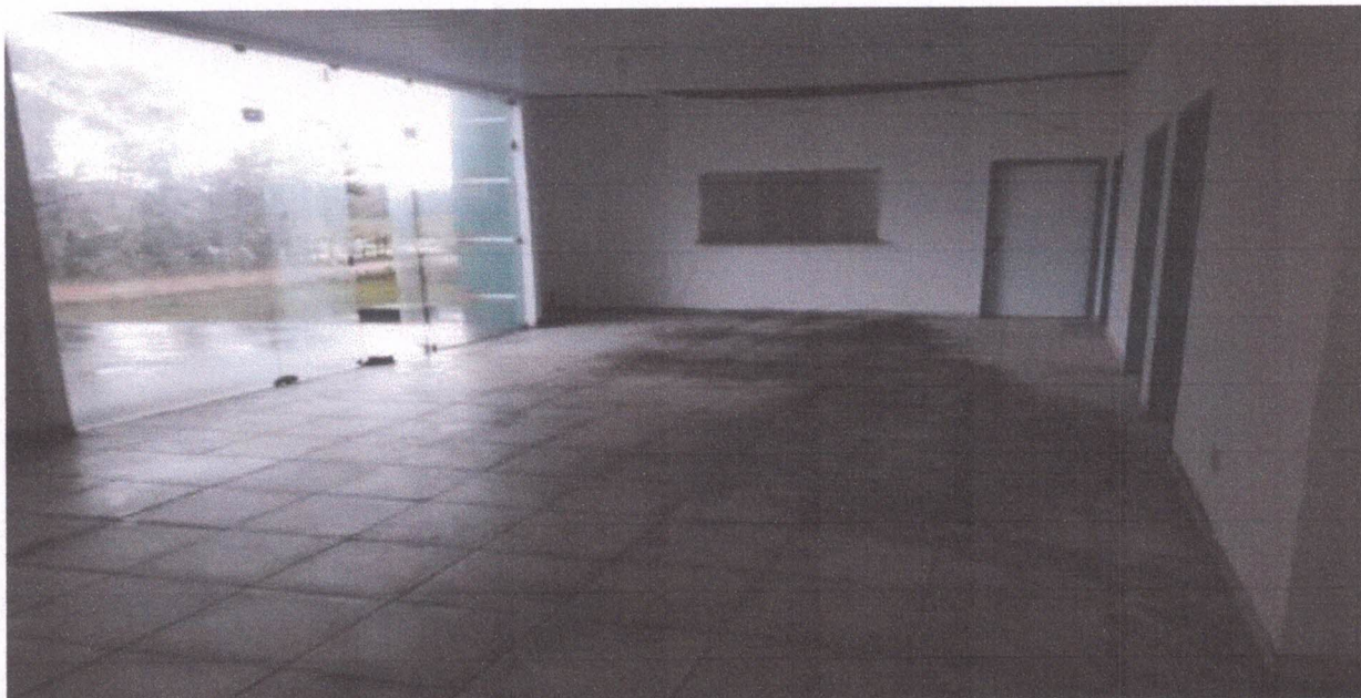
Reg. fotográfico da situação-Engenharia e Fiscalização/SEMUST
