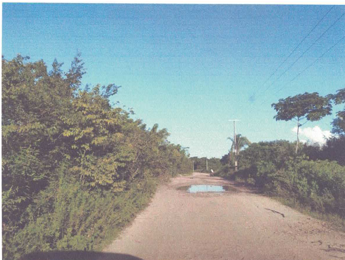
FOTO 18: Trecho da estrada próximo à comunidade da Flexeira. Água da chuva empoçada.
