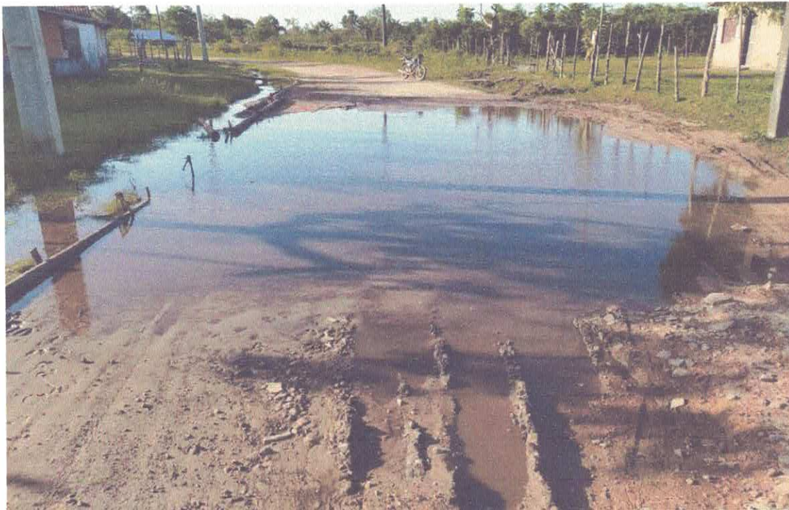
FOTO 15: Estrada na comunidade do Nanã. Água da chuva empoçada.
