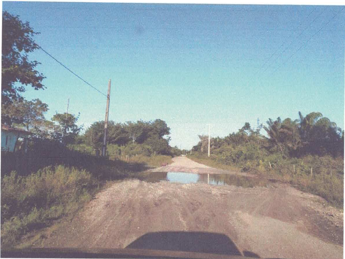
FOTO 16: Trecho da estrada, próximo à comunidade da Flexeira. Água da chuva empoçada.
