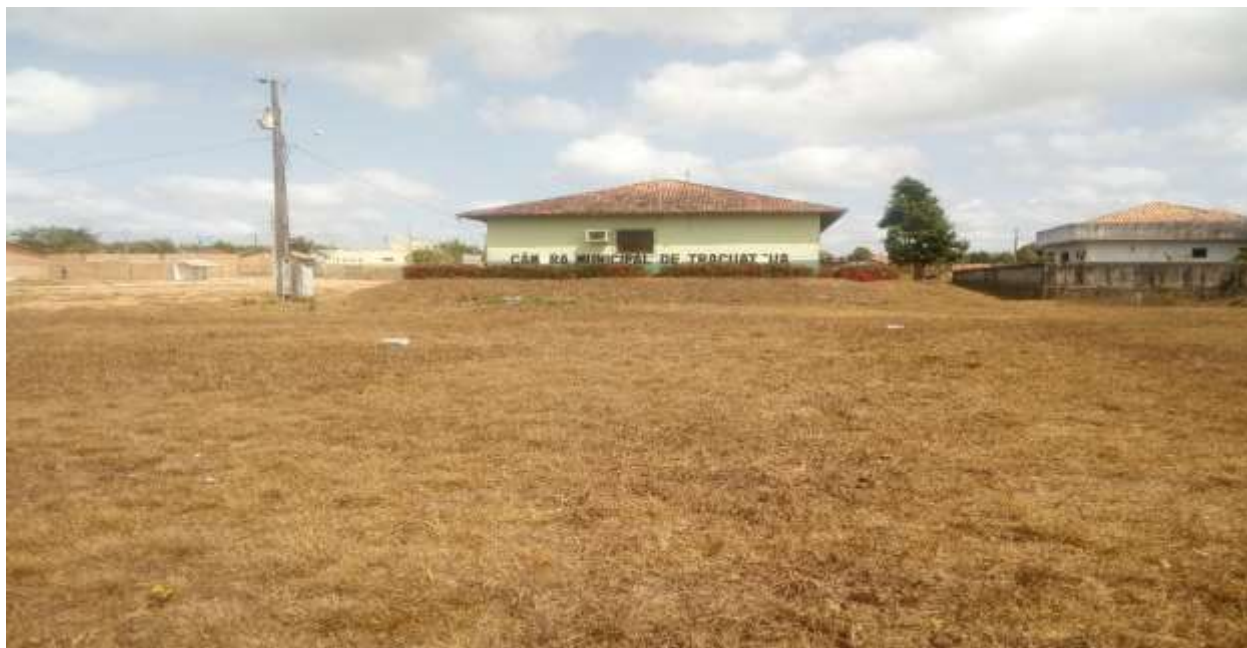
Registro fotográfico da situação-Engenharia e Fiscalização PMT
