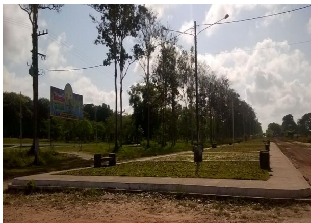
Fotografia - 02, canteiro 04 área sem postes
